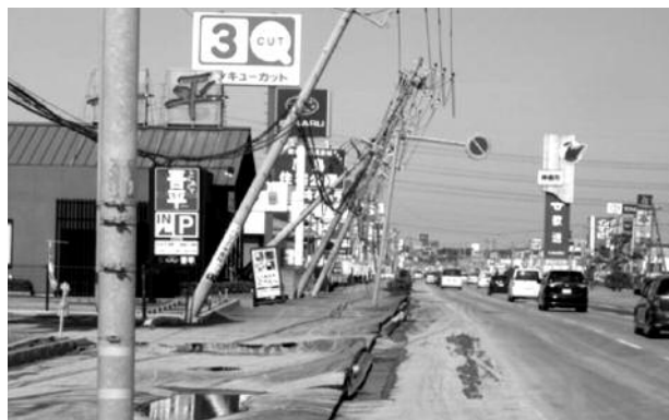
潮来市 液状化と津波で道路は浮き上がるか陥没か波打ったりしている
