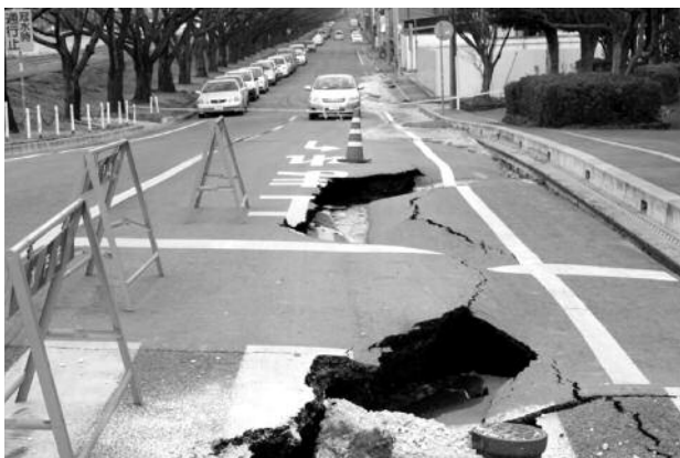
水戸市 道路が割れて水が噴き出した水戸駅南口近く
